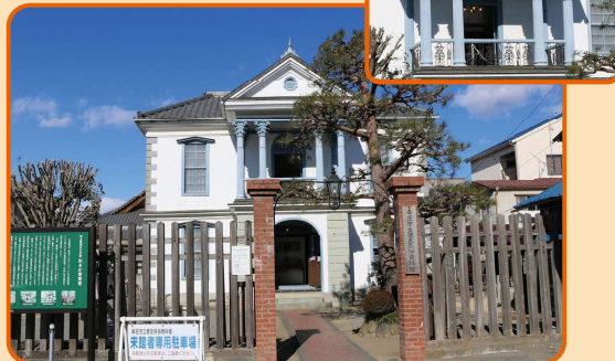
洋風建築の旧本庄警察署の建物を復元しています
