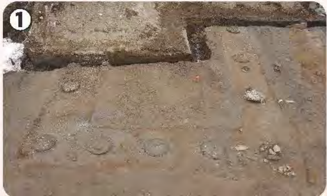
砂や石を詰め込んだ樽を並べた建物の基礎跡で、「樽地業」と呼ばれています。樽は土台の下に配置されています。江戸の技術が栗橋に伝わったことを示すまたとない資料です。
