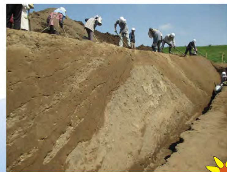
砂の山を芯とした堤防断面写真 (平成26年度調査地点)
